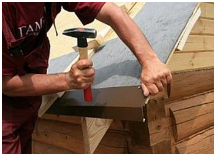
Рисунок 41 –Монтаж торцевых планок
