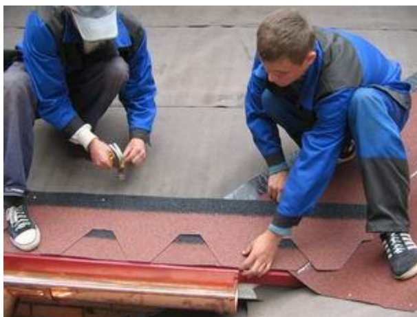
Рисунок 43 – Монтаж битумной черепицы
