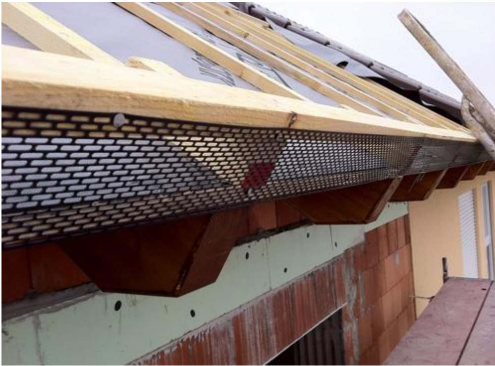
Рисунок 38 – Монтаж контробрешетки
