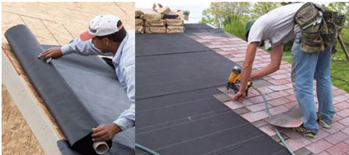
Рисунок 40 – Монтаж подкладочного ковра
