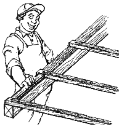
Рисунок 47 – Монтаж обрешетки
